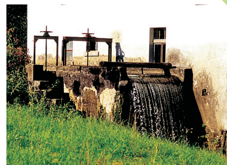
Häufig und durchweg reizvoll: Die Mühlen
